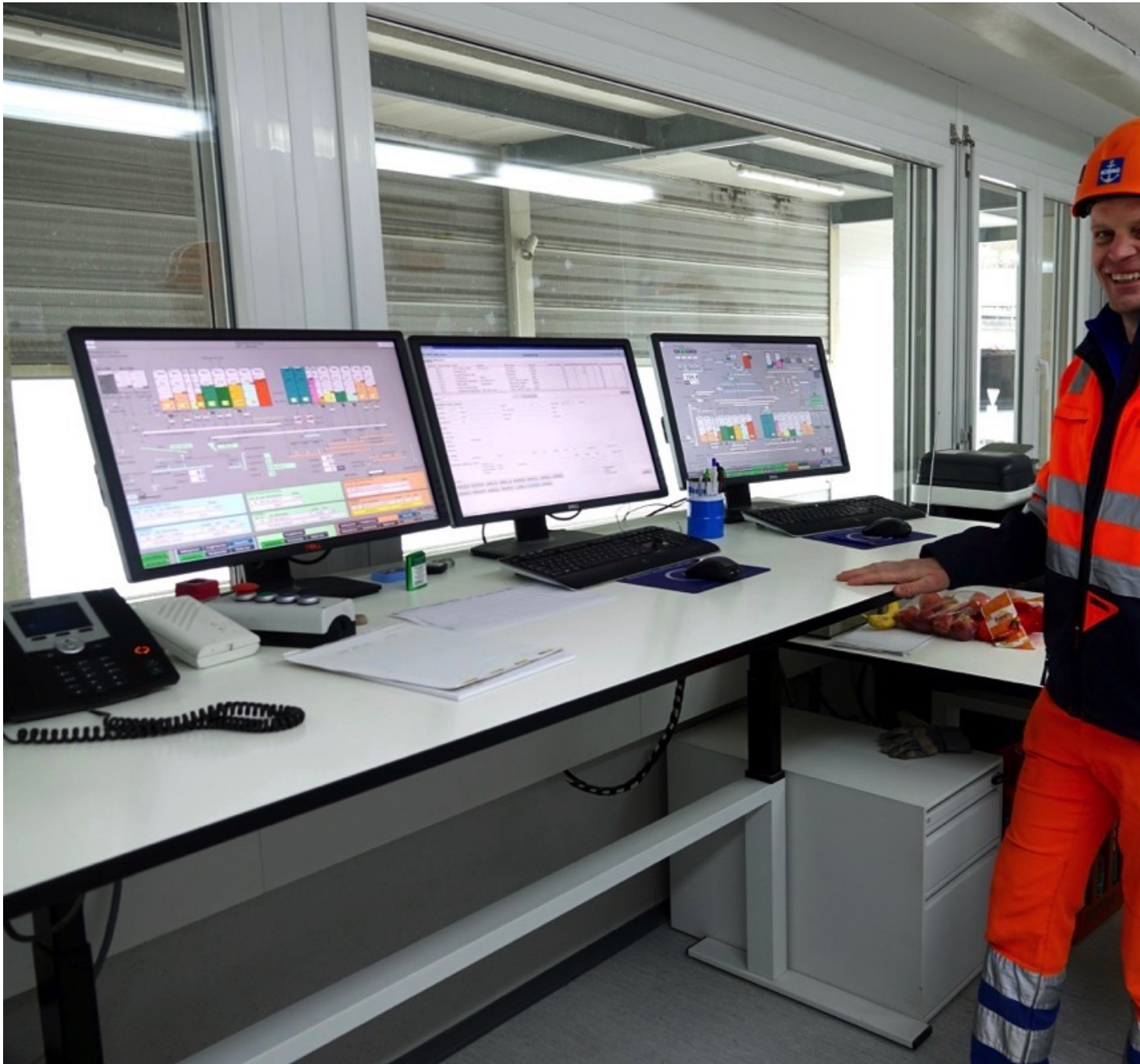
Werkmeister Konrad Schorno in der Leitstelle. (Bild: Drossard)
